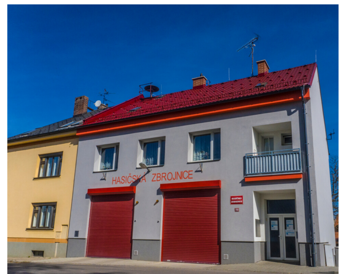
Město Nechanice - Modernizace hasičské budovy v Nechanicích
