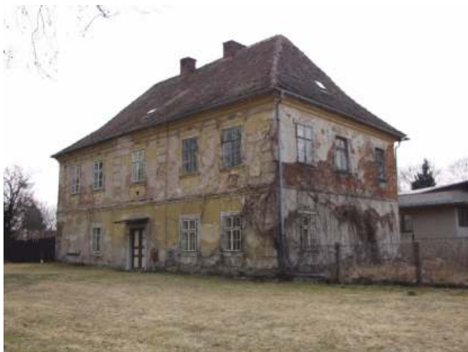
Bývalá fara před rekonstrukcí
