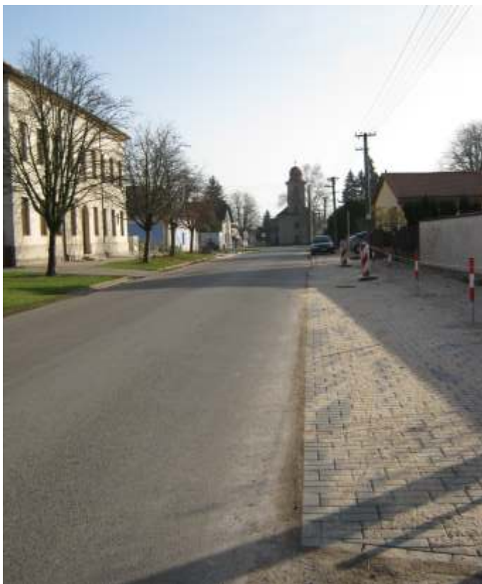
Nové parkování u základní školy Praskačky
